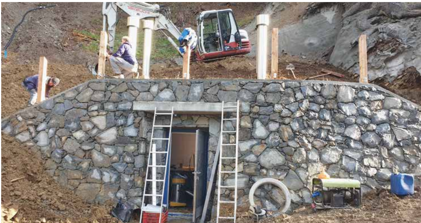
Die Trinkwasserversorgung wird laufend ver- und ausgebessert
