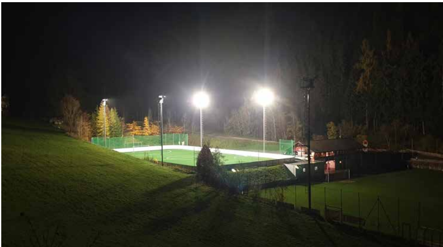
Die neue energiesparende Beleuchtung in der Sportzone
