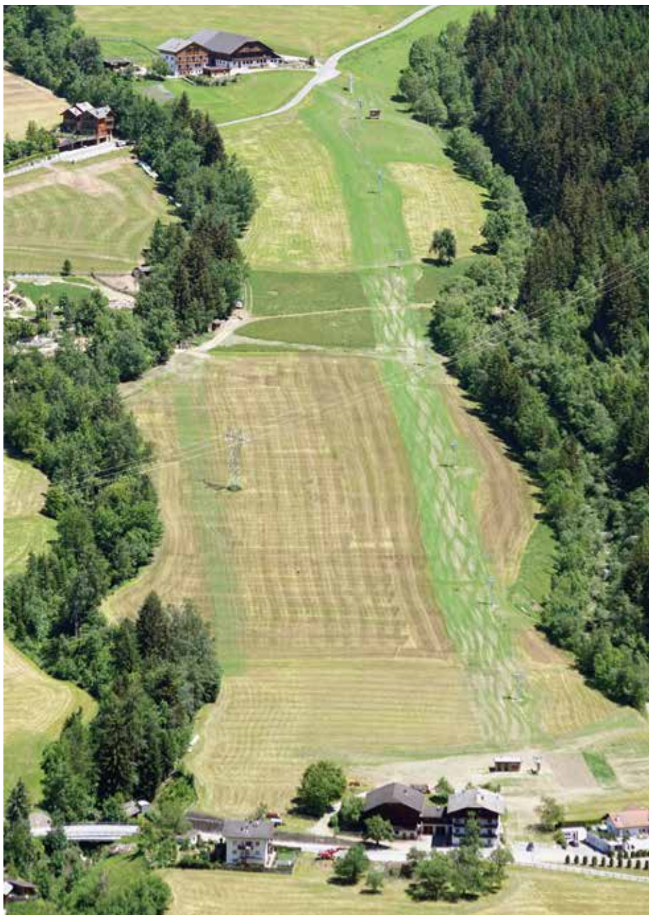
Der Skilift in Rungg wurde komplett erneuert
