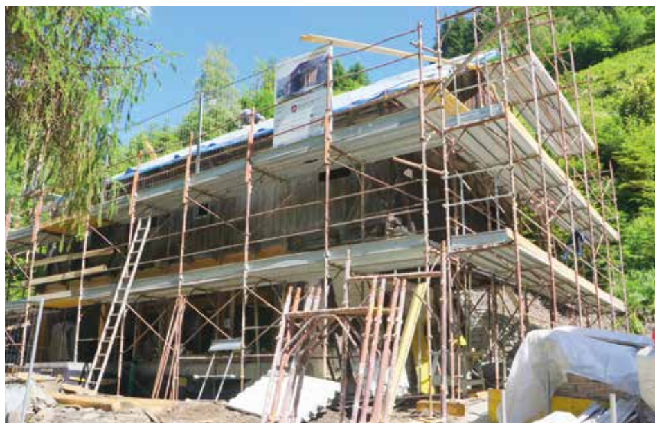
Die Sanierungsarbeiten der „Alten Schmiede“ schreiten voran
