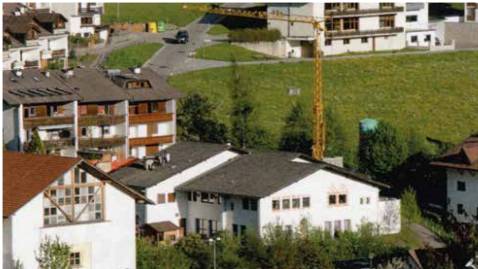
Der Kindergarten vor dem Umbau im Jahr 2009
