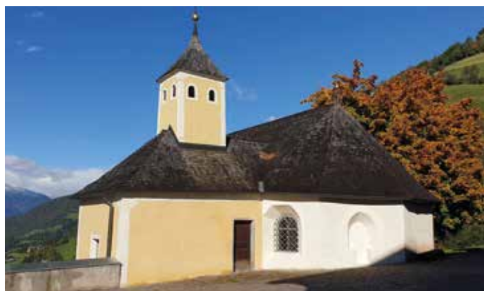
... und nach den Renovierungsarbeiten
